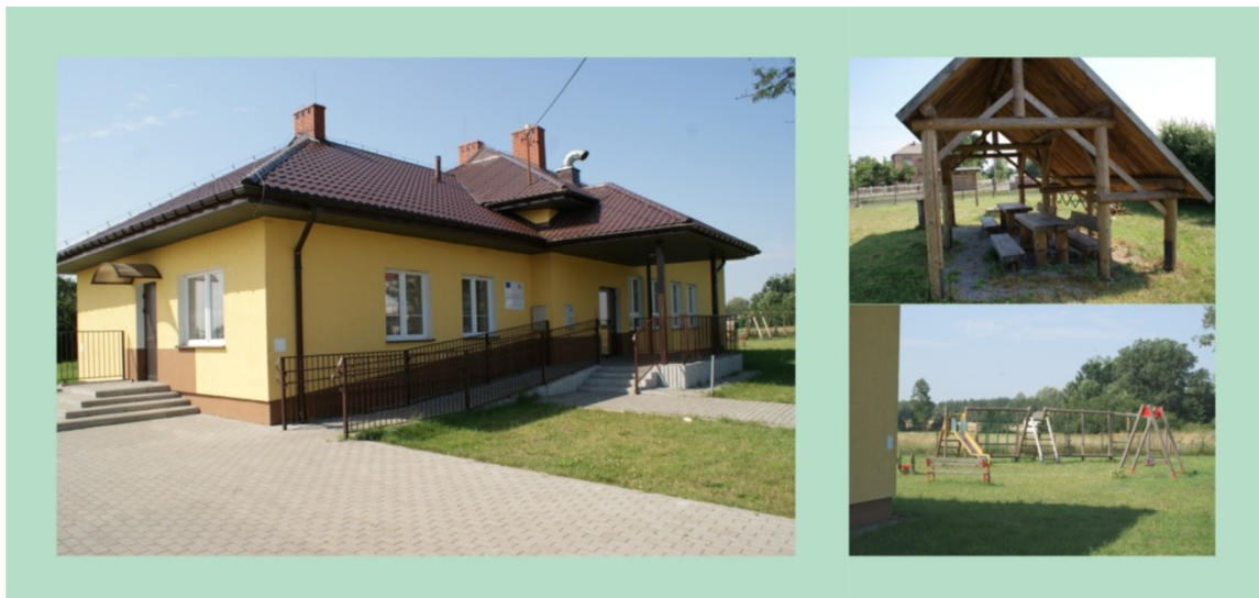
Wyremontowana świetlica w m. Wólka Kątna
