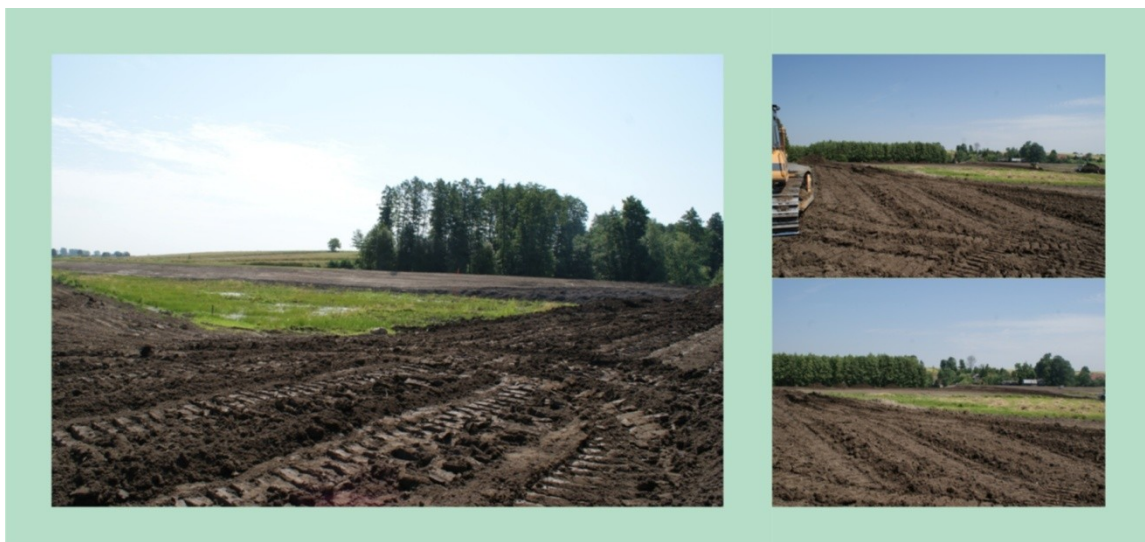
Zbiornik małej retencji w m. Kaleń - etap budowy
