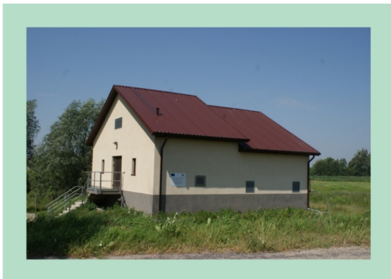
Oczyszczalnia w m. Kaleń
