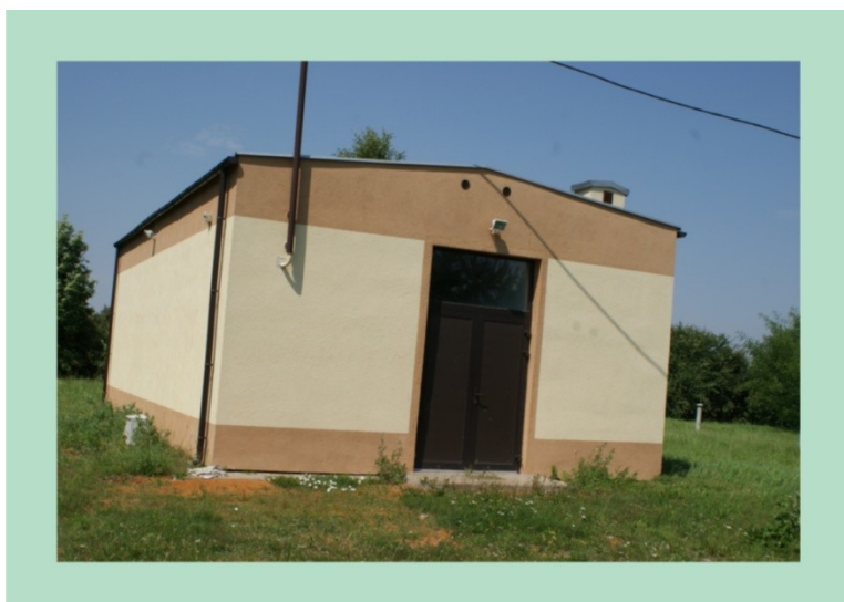
Zmodernizowana hydrofornia w m. Markuszów
