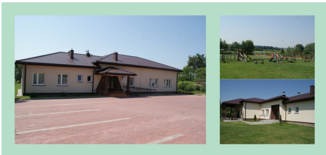
Wybudowana świetlica w m. Łany
