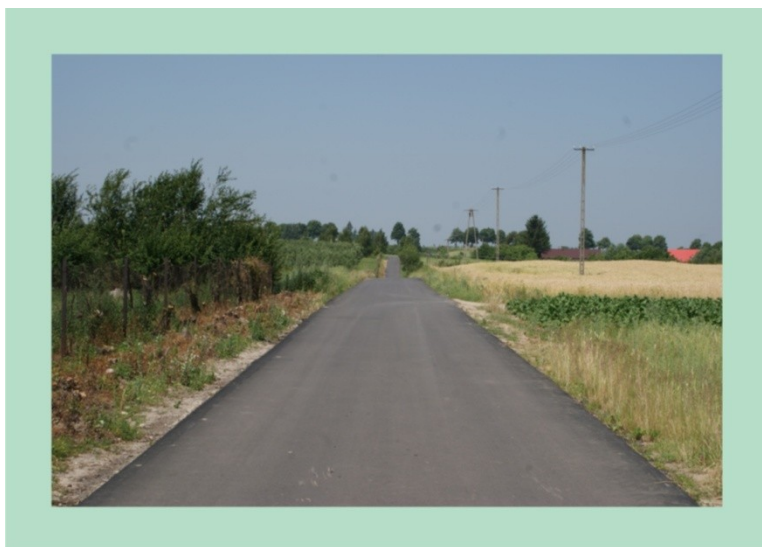
Zmodernizowana droga w m. Góry-Kolonia
